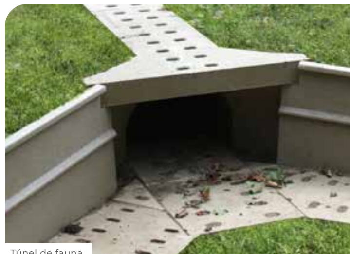
Túnel de fauna
