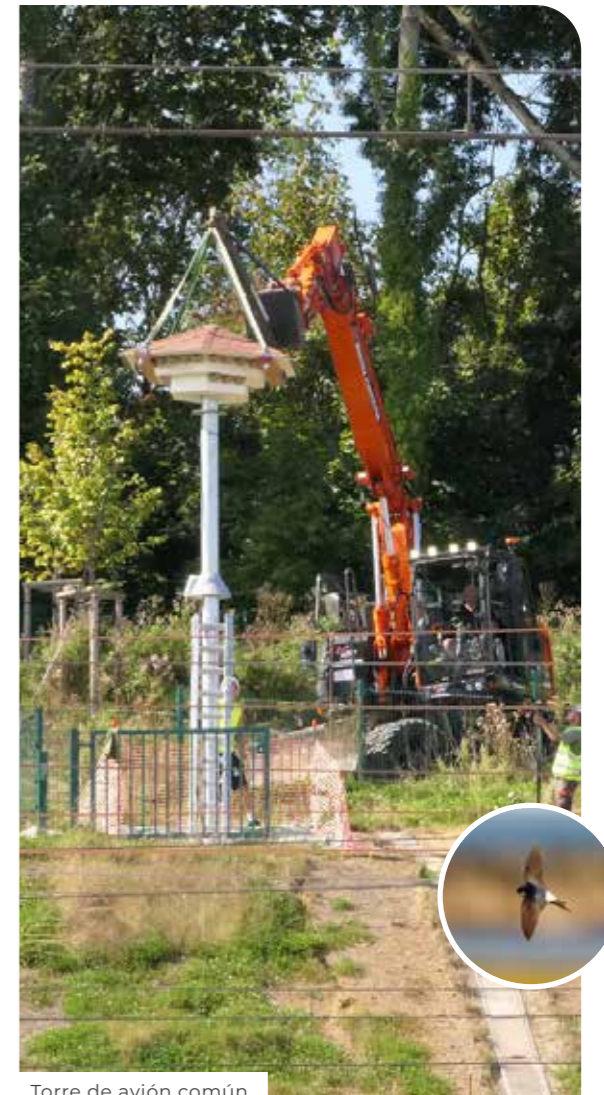
Torre de avión común
